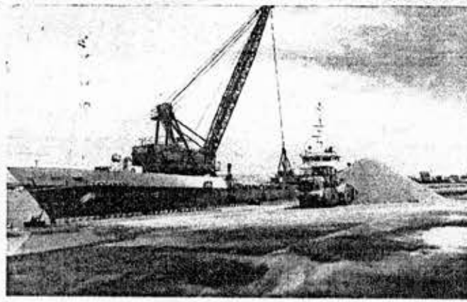
拡張した骨材ヤード
